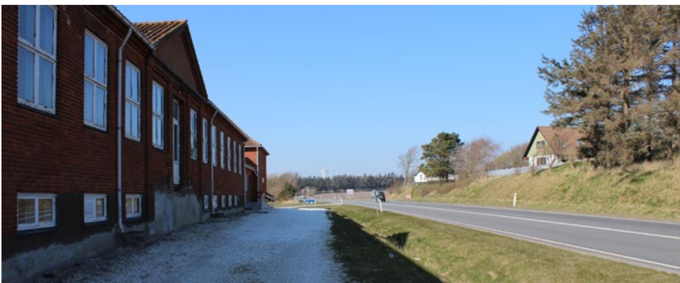
Eksisterende facade på skolebygninger som vender ud mod Thistedvej.
