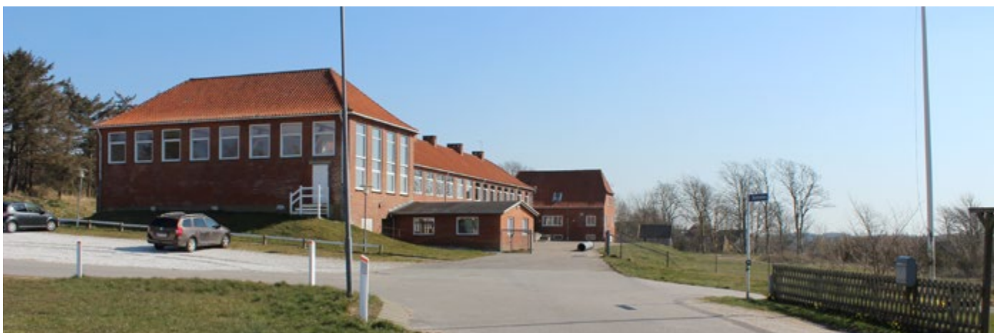
Eksisterende skole bygninger, men den gl. gymnastiksal nærmest, som ønskes anvendt til gildesal/selskabslokale.
