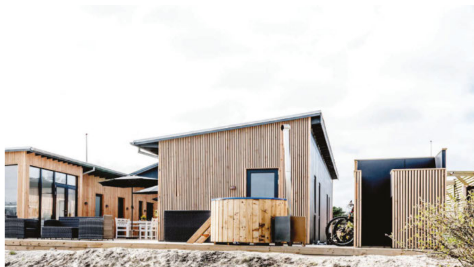
Bygningspræmien 2017 gik til Guest House, Ørhagevej 84, 7700 Thisted
