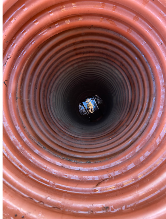
Figur 28: Besigtigelse i brønden. Det vurderes at brønden er ca. 2,5 m dyb. Udløbskote blev ikke målt.
