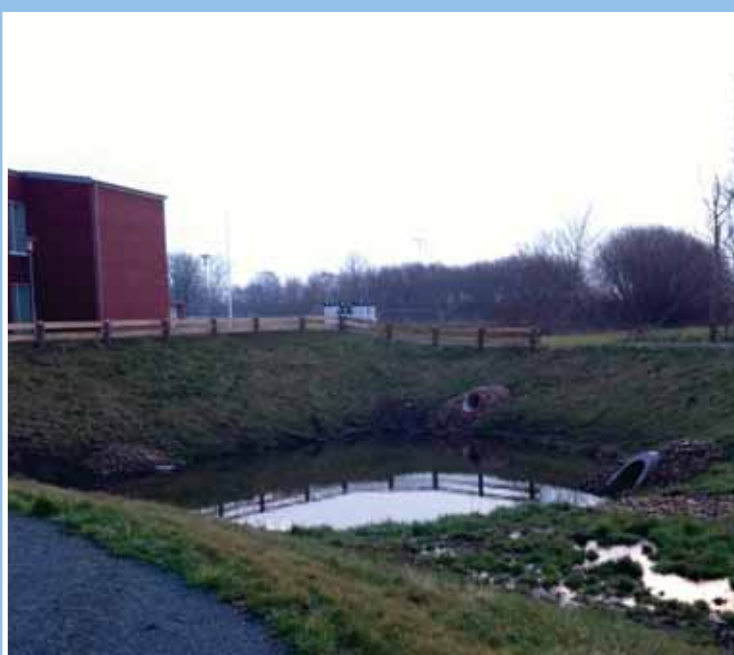
Figur 3: Regnvandsbassin i Koldby
